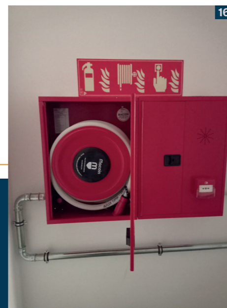
15. Instal·lació de portes tallafoc en un canvi de sector d'una activitat industrial 16. Equips de protecció activa contra incendis en una activitat museu
