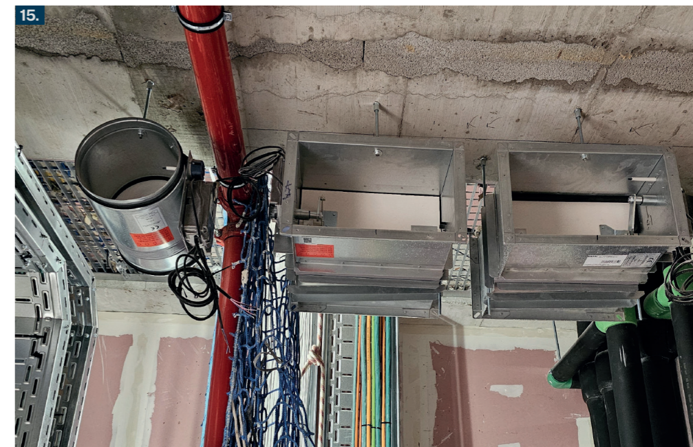
15. Instal·lació de portes tallafoc en un canvi de sector d'una activitat industrial 16. Equips de protecció activa contra incendis en una activitat museu
