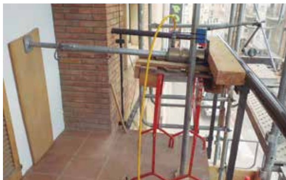
Prova de càrrega en barana.
