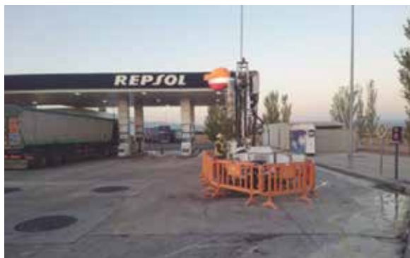
Perforació de sondeigs d'investigació a una Estació de servei.
