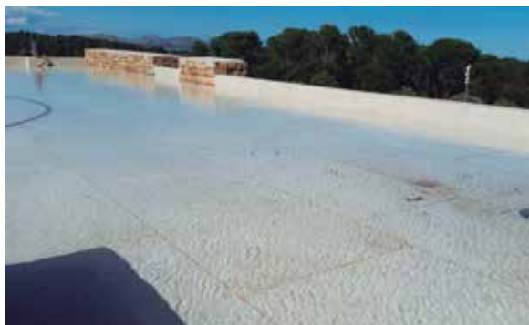
Prova d'estanquitat de coberta per inundació.
