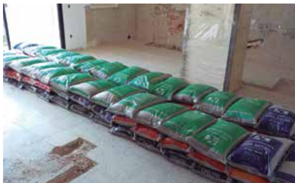
Prova càrrega en estructura de formigó.
