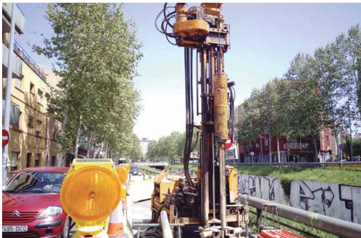
Realització d'un sondatge a Girona per la construcció del Pont del Dimoni amb la sonda TP50-D.
