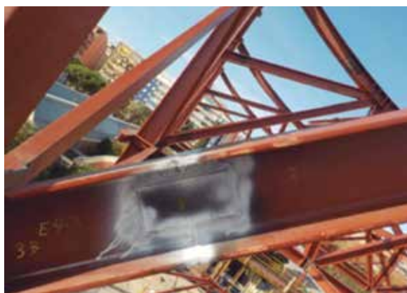
Detall de comprovació de soldadura al poliesportiu Camp del Ferro de Barcelona.
