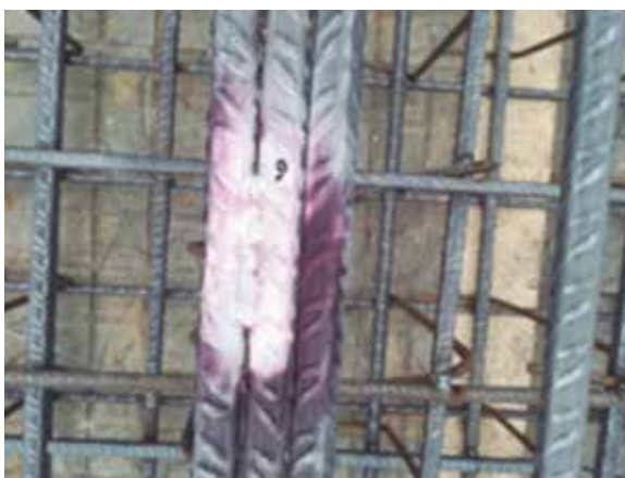
Inspecció L.P. ferralla.
