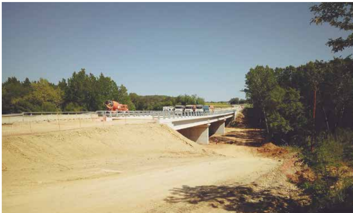
Prova càrrega viaducte.
