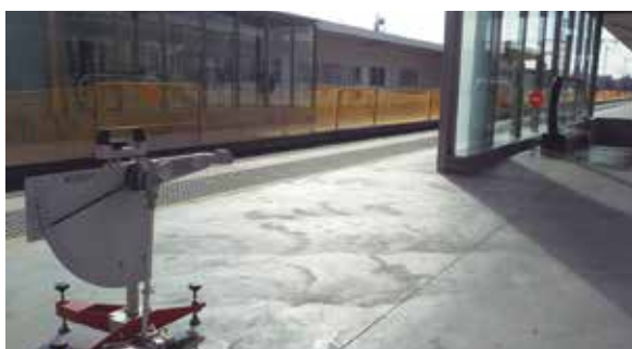
Assaig de lliscament a obra.
