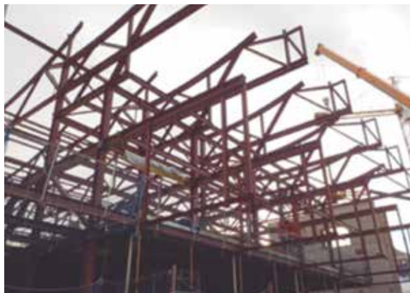
Estructura en ferro del poliesportiu de Camp del Ferro a Barcelona.
