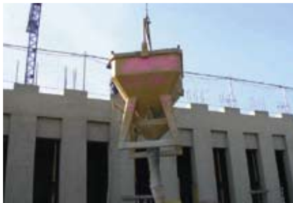
Foto 3: Vessament del formigó per mitjà de cubilot.
