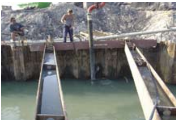
Foto 5: Vessament del formigó sota l'aigua.
