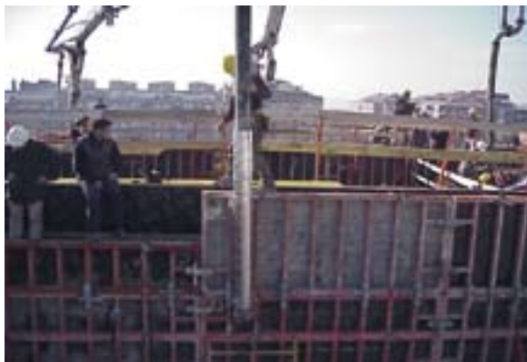
Foto 1: Utilització de bombes per a la col·locació del formigó
