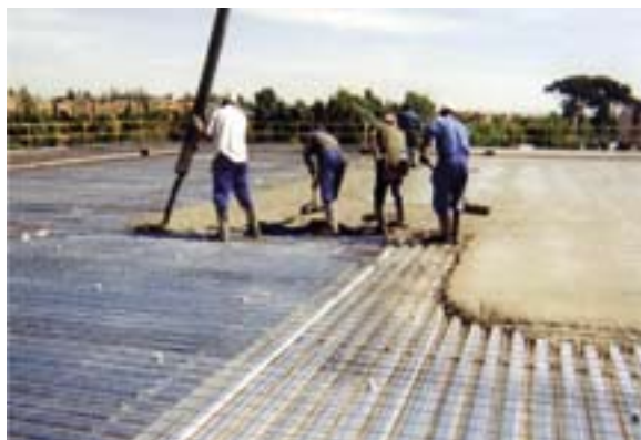
Operaris requerits per a la construcció d'un forjat amb formigó autocompactant (requereix solament dos operaris) i amb formigó convencional (en requereix cinc).
