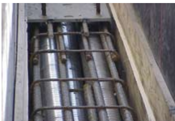
Foto 2: Quantitats d'armadura que justifiquen l'ús d'aquests formigons.
