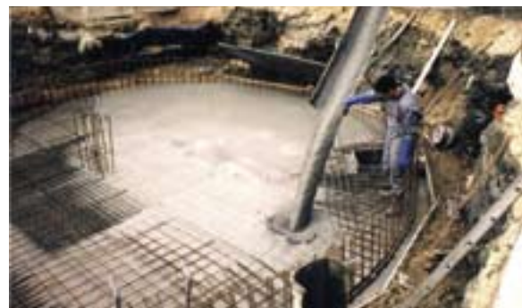
Construcció amb formigó autocompactant.
