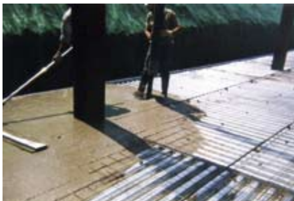
Operaris requerits per a la construcció d'un forjat amb formigó autocompactant (requereix solament dos operaris) i amb formigó convencional (en requereix cinc).
