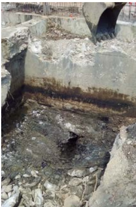
Excavació de sòls afectats per fuel.
