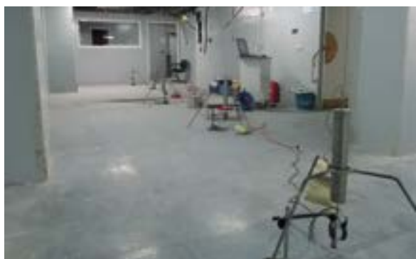
Prova càrrega en forjat reticular.
