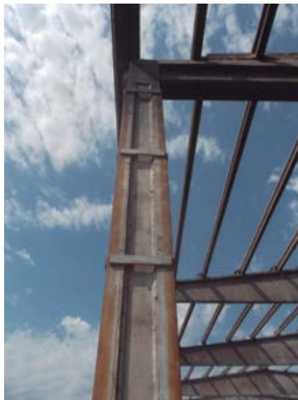
Avaluació d'una estructura afectada pel foc.
