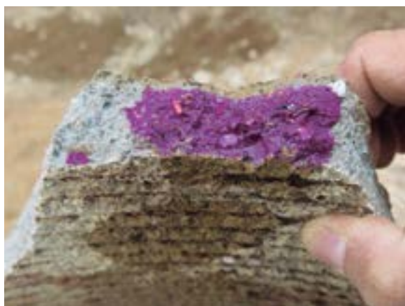
Comprovació carbonatació in situ .
