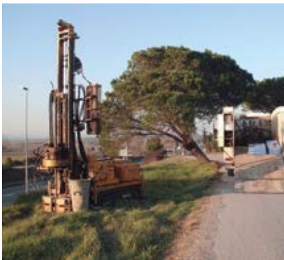
Realització d'un sondatge adjacent a la N-II, a Vidreres, per a la construcció de l'A-2.
