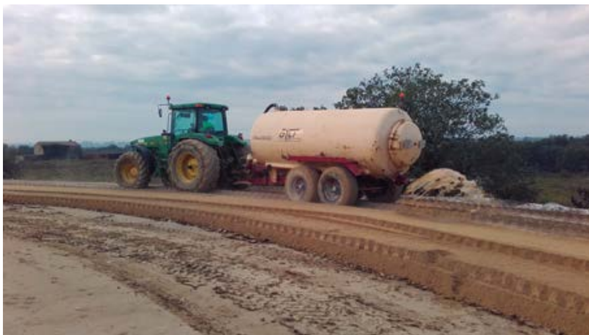
Control de l'estabilització del sòl a l'abocador de Pedret i Marzà.
