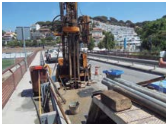
Realització d'un sondatge a una de les piles del pont sobre la riera, a Sant Pol de Mar.
