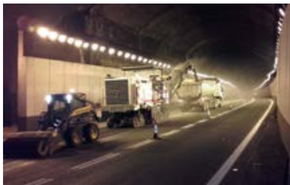
Control del reasfaltat dels Túnel de Vallvidrera.
