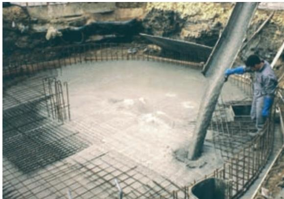
Foto 2. Execució d'una llosa amb formigó autocompactant.
