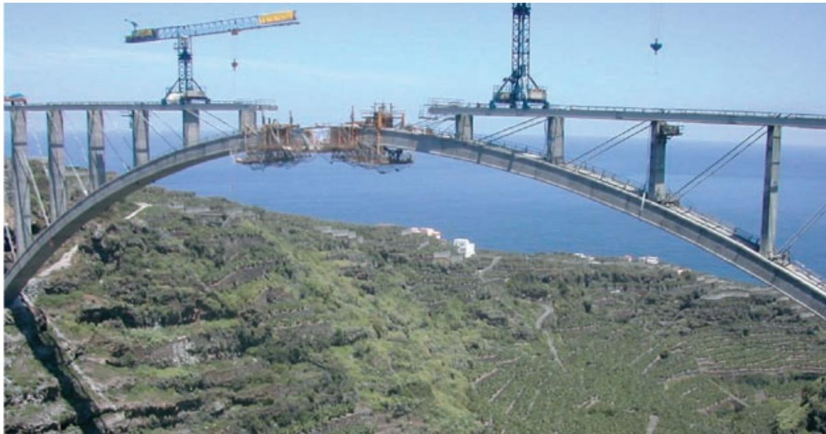
**Foto 1.** Pont arc de Los Tilos (La Palma, Canàries), executat amb formigó d'altres prestacions.
