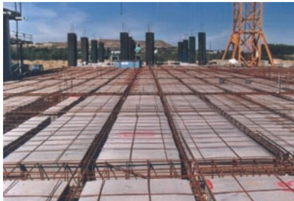
**Foto 5.** Forjat unidireccional amb armadura bàsica en gelosia, construit *in situ*.
