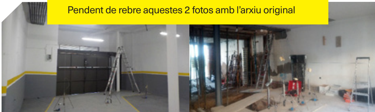
Proves de càrrega en estructura de formigó
